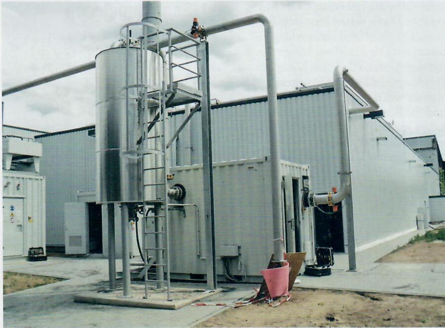
Aktivkohlefilter gibt es aus Edelstahl oder Kunststoff, als fest installierte Anlage oder als mobile Version in Form eines Pfandsystems.
