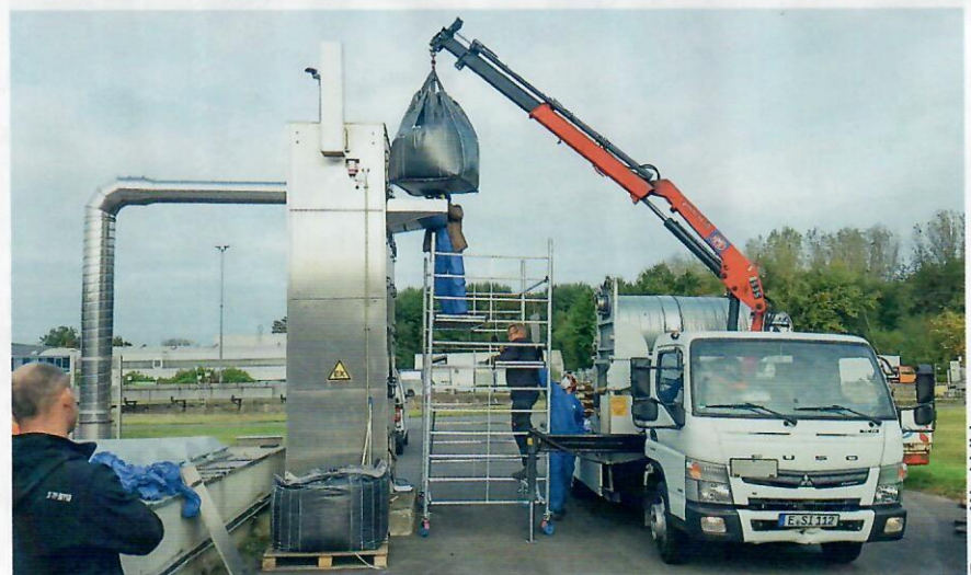
Der Aktivkohlefilter sollte so aufgestellt werden, dass man mit dem Lkw zum Be- oder Entladen nach dem Filterwechsel danebenfahren kann.
